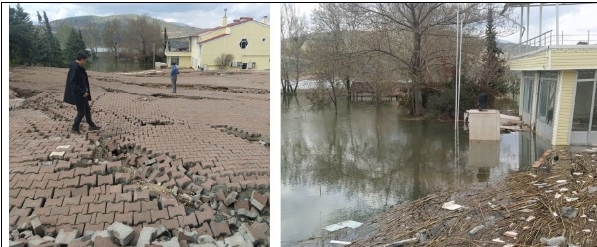
Figura 6. Gölbaşı: Effetti di lateral spreading per liquefazione dei terreni sulle sponde del lago.
