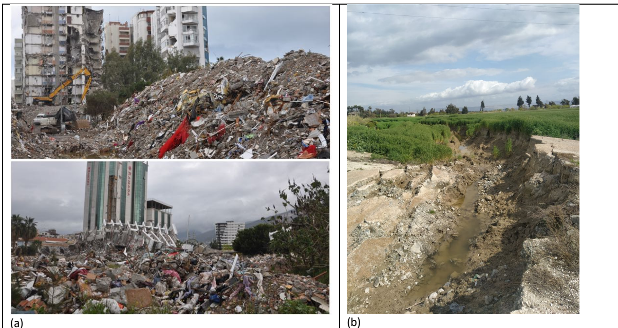
Figura 3. (a) Edifici residenziali crollati a Iskenđerun; (b) effetti di lateral spreading per liquefazione dei terreni lungo le rive del fiume Oronte nelle vicinanze della città di Antakya (Hatay).
